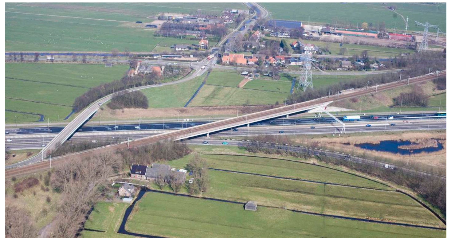
figuur 1.2 luchtfoto bestaande betonnen brug
