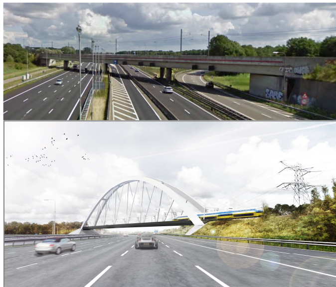
Figuur 1 Zicht op de betonnen spoorbrug vanuit de bestaande A1 (boven) en een impressie van de toekomstige stalen-betonnen spoorbrug over de A1 (onder).
